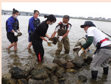
石干見補強作業
